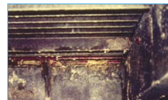
Après le nettoyage du système – les conséquences de la contamination microbienne (corrosion imputable aux microorganismes)
